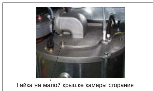
Рис.: Гайка на крышке камеры сгорания
