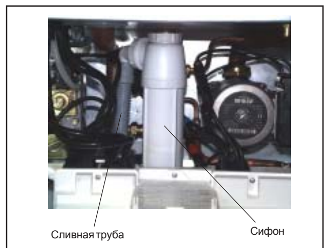
Рис.: Подключение сифона
