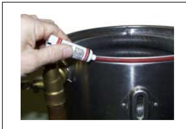
Рис.: Все уплотнения смазать силиконовой смазкой.
