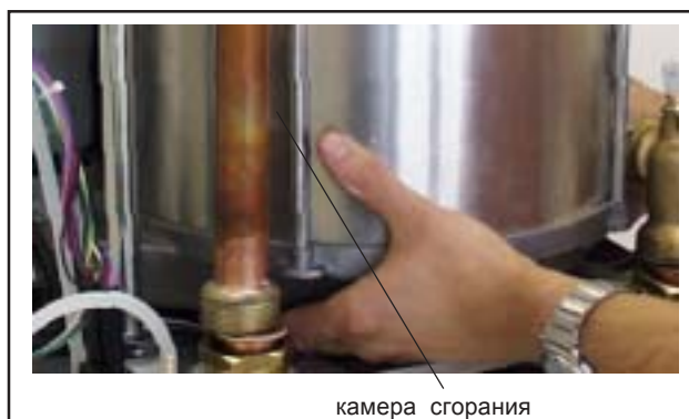
Рис: Камера сгорания
