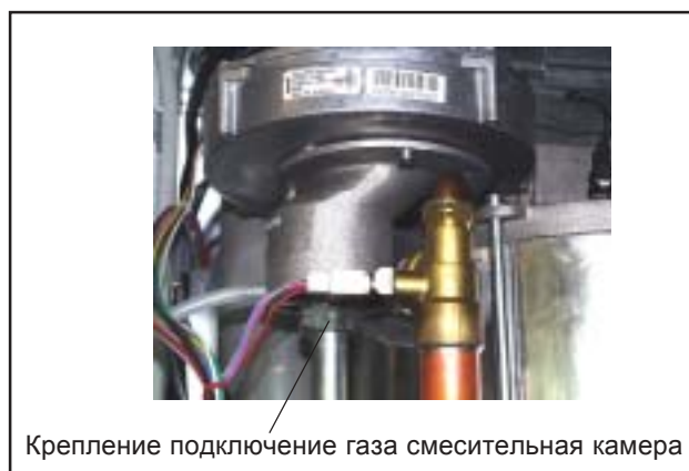
Рис.: Крепление подключение газа смесит. камера
