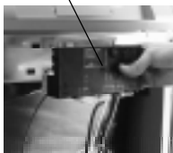
Резьбовое соединение комбинир. газового клапана
