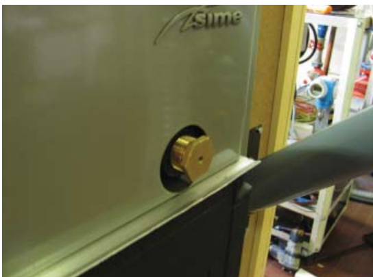
Εικ. 27 Ορειχάλκινος μειωτήρας
