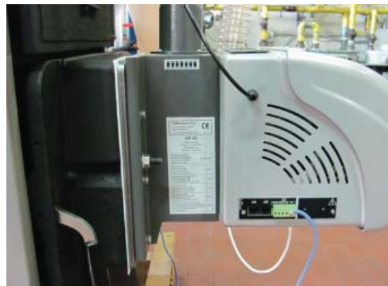
Εικ. 26 Στερέωση καυστήρα
