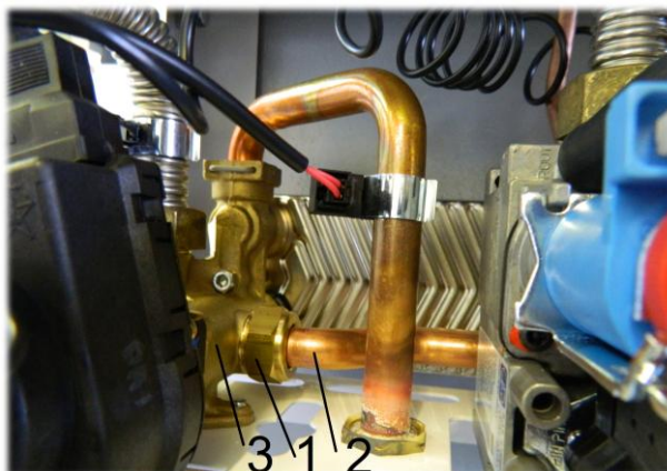
Рис. 28. Демонтаж клапана байпаса
