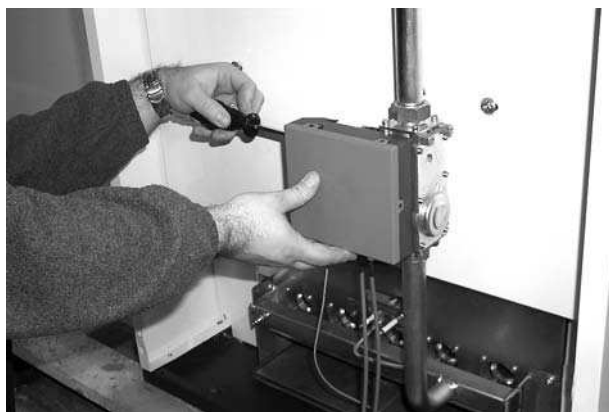
рис. 7 - Открутите два винта крепления блока управления
