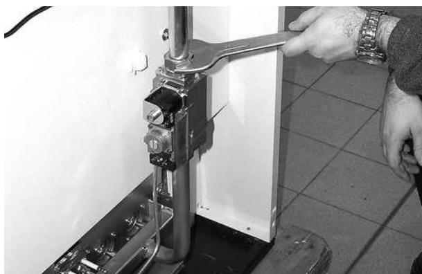
рис. 9 - Открутите гайку крепления газового клапана
