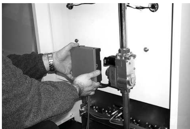
рис. 8 - Снимите блок управления
