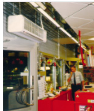
Свободная подвеска с потолка на гибких тягах
