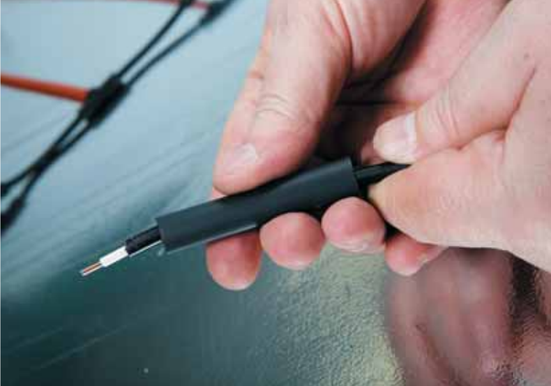
Рис. 10. Процесс надевания термоусаживаемой трубки на соединительный провод ВВГнг
