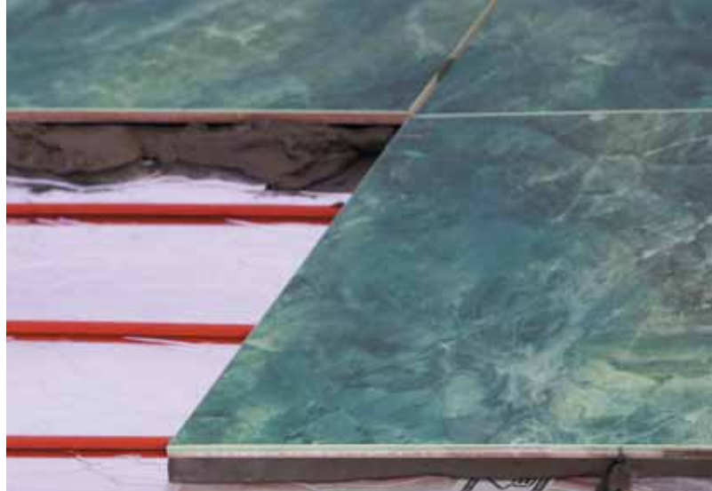
Рис. 24. Монтаж керамической плитки поверх карбонового мата UNIMAT
