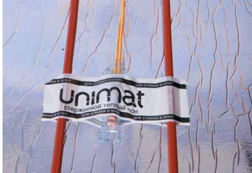
Рис. 18. Установка датчика температуры пола SF-7x30 между стержнями UNIMAT
