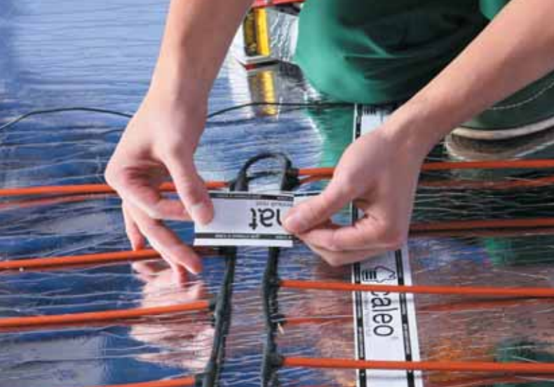
Рис. 6. Фиксация полос UNIMAT скотчем
