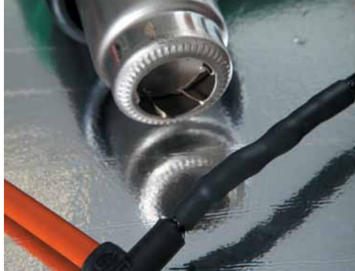
Рис. 13. Усадка термоусаживаемой трубки техническим феном
