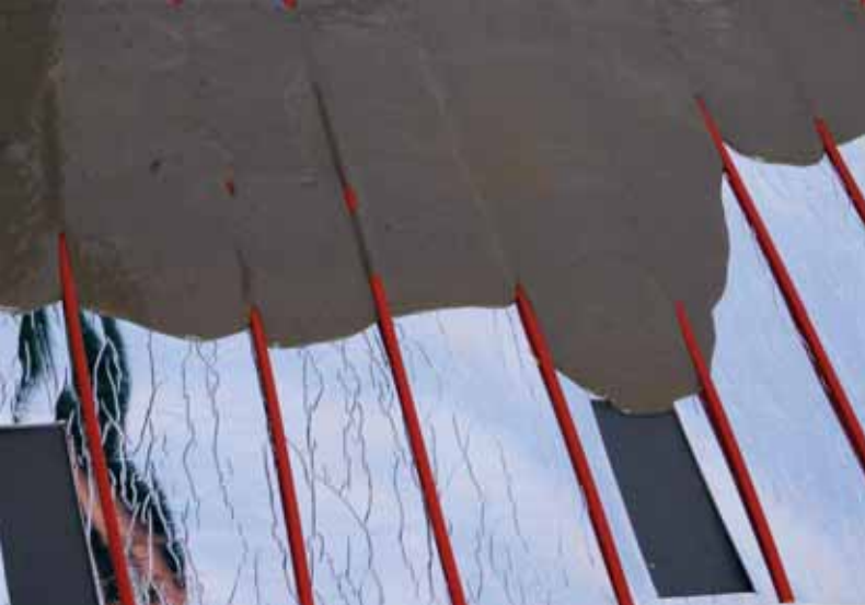
Рис. 22. Залейте стяжку пола поверх стержней теплого пола UNIMAT
