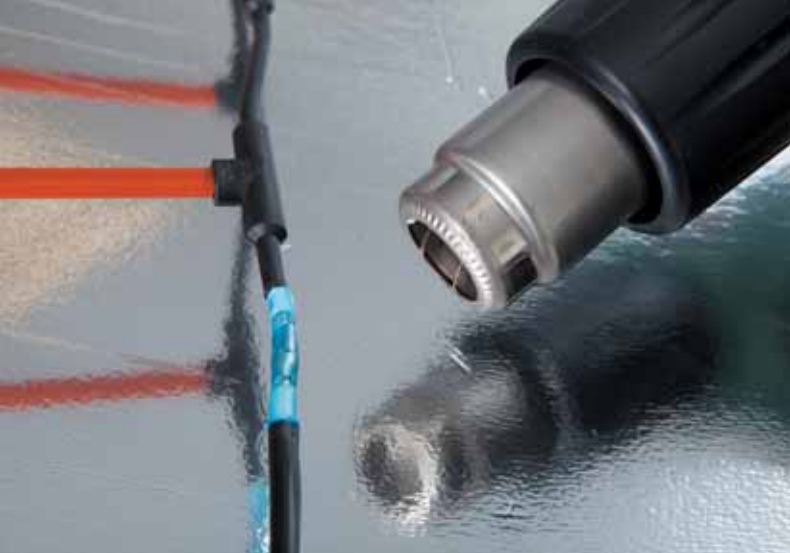
Рис. 12. Термоусадка соединительной гильзы техническим феном
