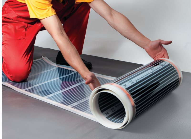
Рис. 5. Раскатывание рулона теплого пола на теплоотражающем материале
