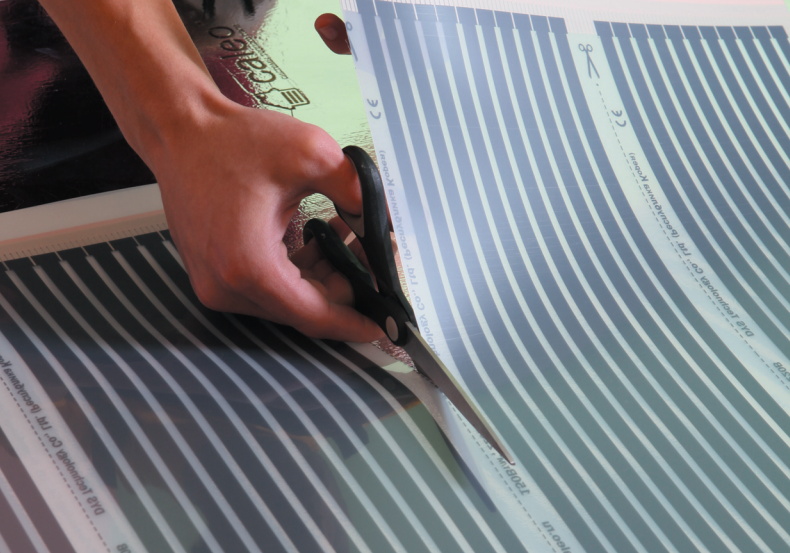
Рис. 7. Разрезание термопленки CALEO по линиям отреза
