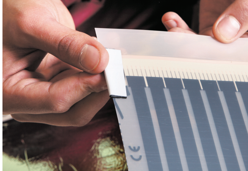
Рис. 14. Окончание процесса изолирования линии отреза медной шины
