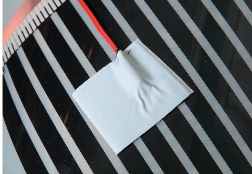
Рис. 25. Установленный и приклеенный датчик температуры пола. Вид снизу термопленки
