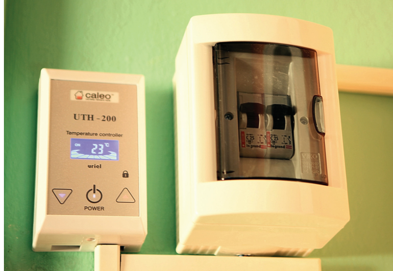
Рис. 27. Терморегулятор, подключенный к сети через отдельный автомат
