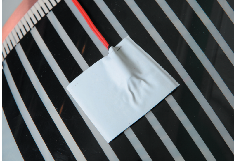
Рис. 25. Установленный и приклеенный датчик температуры пола. Вид снизу термоплёнки
